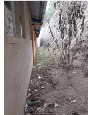
Imagen 102. Disminución de la contaminación ambiental Fuente: elaboración propia,
