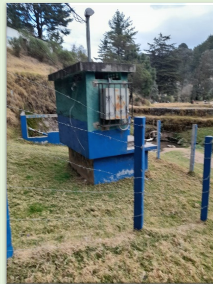
Imagen 7. Construcción existente. Fuente: (Elaboración propia)
