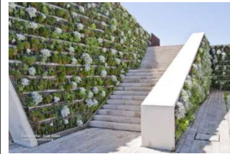
Imagen 108. Paredes verdes Fuente: “MUROS VERDES – Revista Landuum.” 2022. Landuum.com. 2022. https://www.landuum.com/laboratorio/muros-verdes/ .
