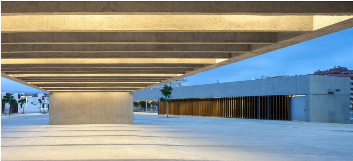
Imagen No. 21. Celosías en caminamientos con iluminación cenital natural. Fuente: Roig Joan. https://www.archdaily.cl/cl/927137/regeneracion-urbana-parque-de-los-bajos-emac/5db19fb43312fd223f0004be-regeneracion-urbana-parque-de-los-bajos-emac-foto
