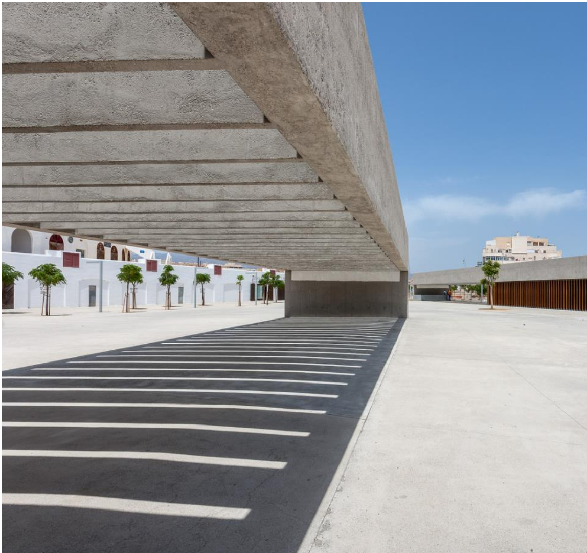
Imagen No. 20. Celosías en caminamientos con iluminación cenital natural. Fuente: Roig Joan. https://www.archdaily.cl/cl/927137/regeneracion-urbana-parque-de-los-bajos-emac/5db19fb43312fd223f0004be-regeneracion-urbana-parque-de-los-bajos-emac-foto
