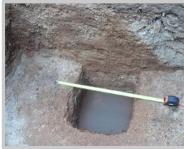
Figura 4. Fotografía de pruebas de infiltración de suelo Fuente: elaboración propia
