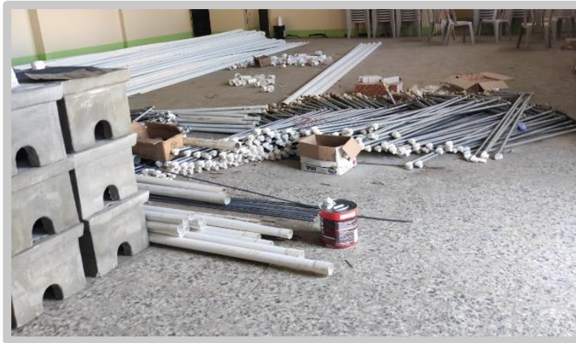
Figura 12. Fotografía de entrega y acondicionamiento de materiales para el proyecto de aldea Cajolá Chiquito, Cajolá, Quetzaltenango.
