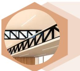
La cubierta del área deportiva está conformada por vigas de acero de alma vacía para cubrir luces de 23.00 en el sentido vertical colocadas a cada 6.00, mismas que soportaran vigas de 42.00 mts de luz para generar la ventilación e iluminación cenital en la parte central del polideportivo y contará con un panel tipo sándwich para el cerramiento horizontal.
