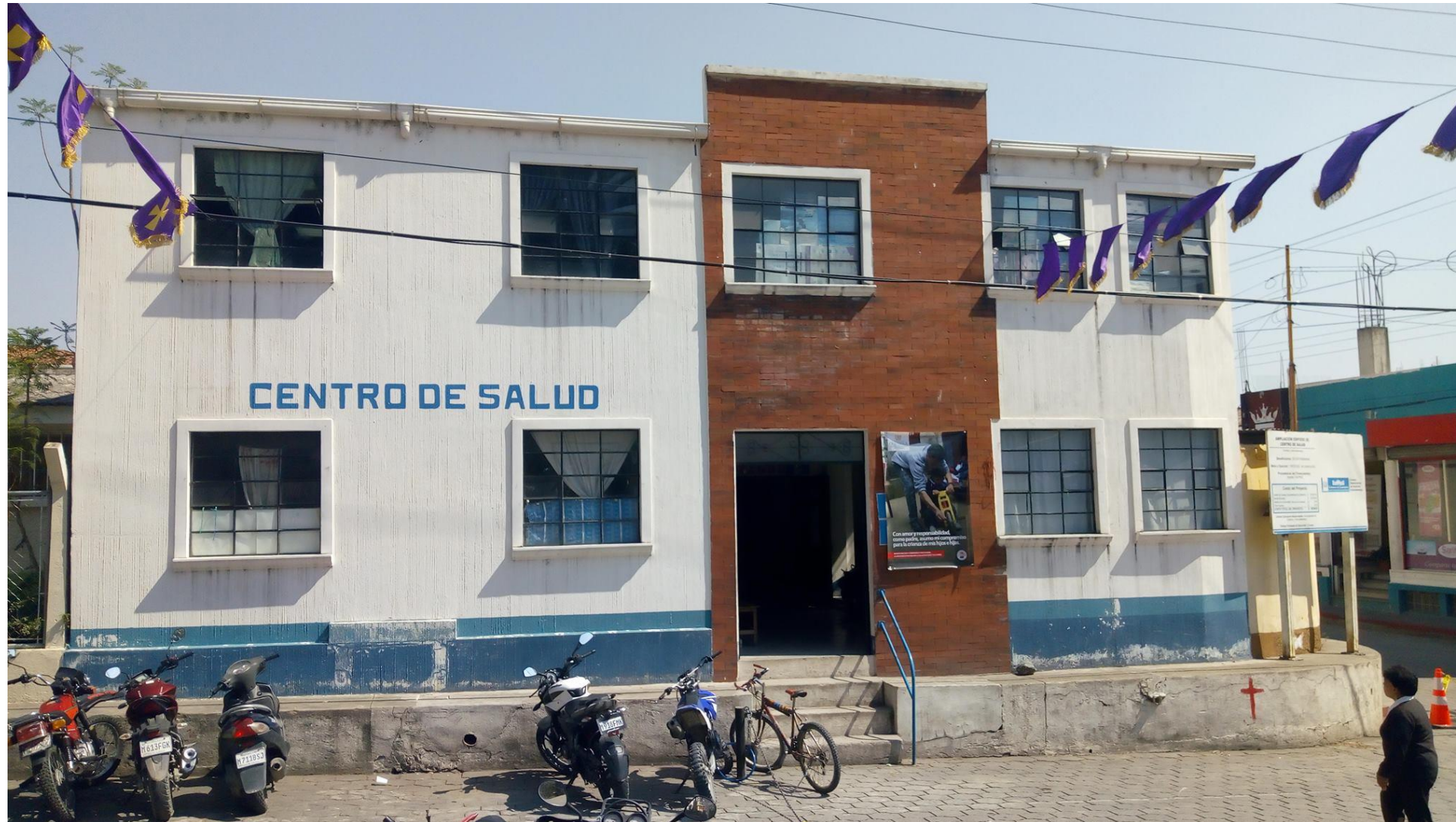
Centro de Salud Chiantla, Fachada principal, 12 de abril de 2019
