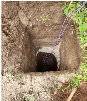
Fotografía 3. Calicata para extracción de muestra inalterada
