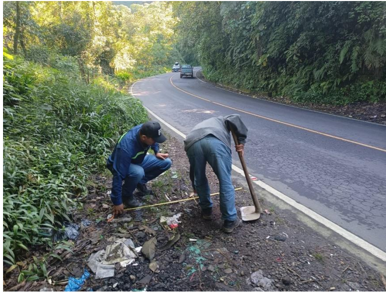
Fotografía 8. Instalación de Rótulo de Identificación en kilómetro 237+000
