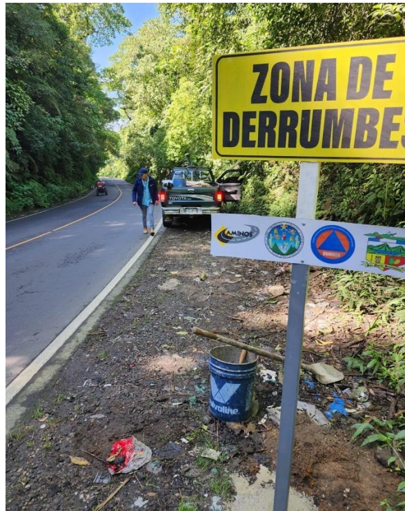
Fotografía 9. Señalización instalada en el kilómetro 237+000
