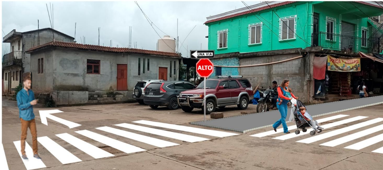
Imagen: Detalle de paso peatonal y señalización vertical entre 6ta calle y 7ma Av.
