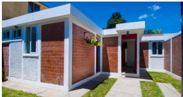
Ilustración 28. Estructura de ladrillo.
