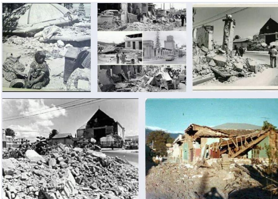
Ilustración 121. Daños ocurridos por el terremoto de 1976 en Guatemala.
