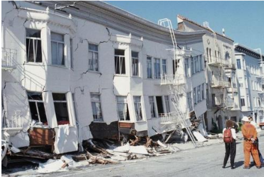
Ilustración 30. Fallo por piso fuerte-piso débil.
