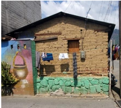
Fotografía No.63 Sistema constructivo típica Adobe
