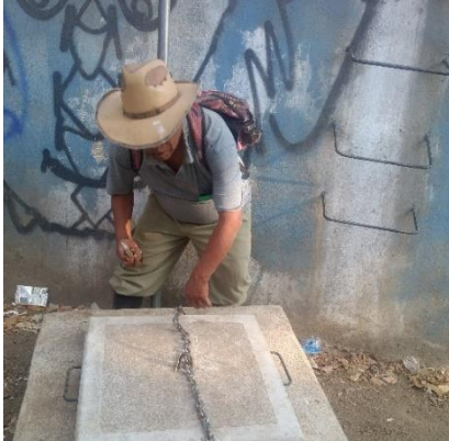
Fotografía No.46 Tanque de cloración de agua potable.
