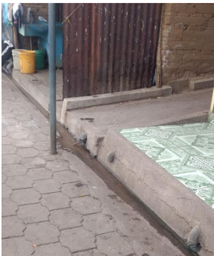
Fotografía No.47 Cunetas pluviales usadas para desfogar desechos de viviendas
