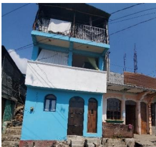
Fotografía No.64 Sistema constructivo Mampostería
