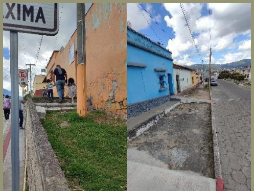
Fotografía 59 - Desnivel de calle e ingresos vehiculares improvisados
