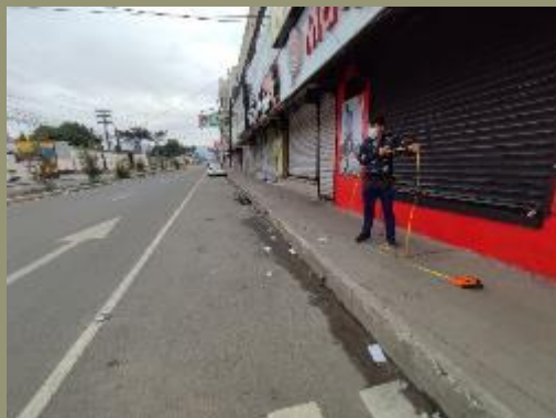
Fotografía 51 - Estado actual de la calle en Manzana 10
