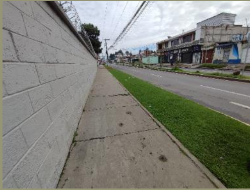
Fotografía 53 - Área de acera en Manzana 11
