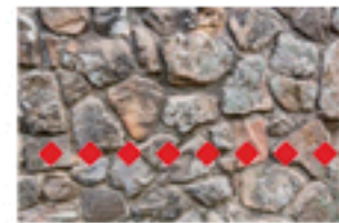
PIEDRA DE RÍO SAMALA BASE PARA CIMENTACIÓN VISTA
