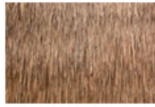
PAJA CUBIERTA SOBRE LAMINA
