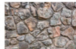
PIEDRA DE RÍO SAMALA BASE PARA CIMENTACIÓN VISTA
