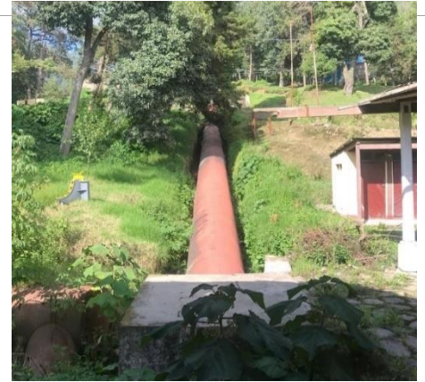
Imagen 53: Antigua Hidroeléctrica de Zunil, Quetzaltenango. Fuente propia. Año 2020
