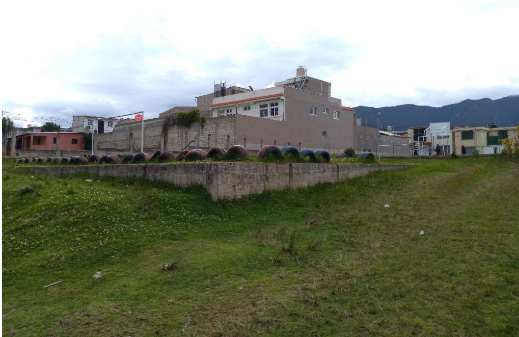
Imagen 50, vista 2 de cancha de futbol existente Fuente: Elaboración propia
