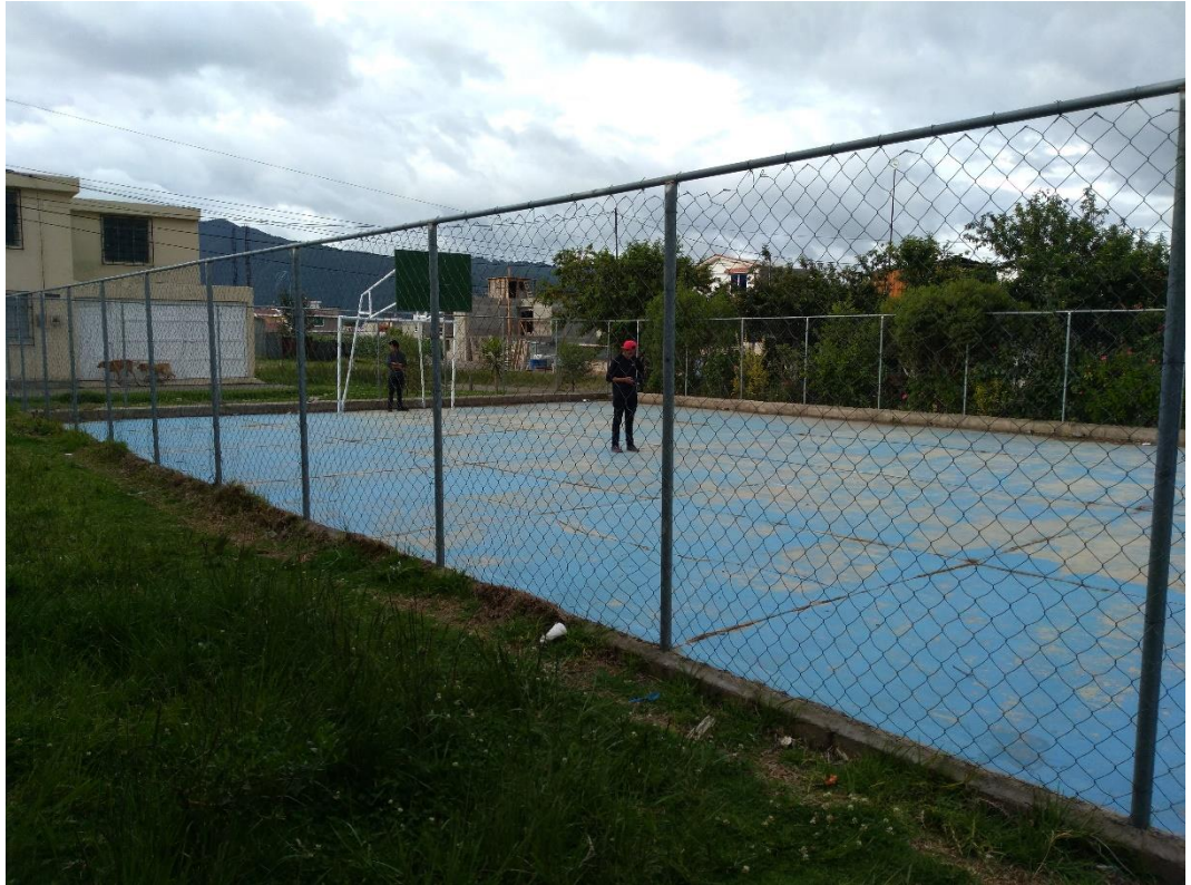
Imagen 51, Cancha polideportiva existente Fuente: Elaboración propia
